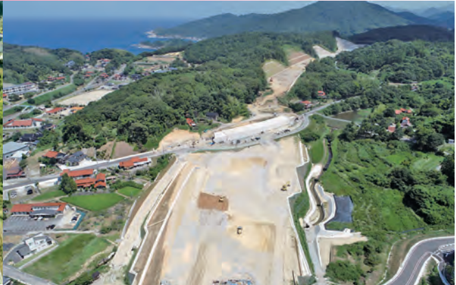
▲鎌手 IC 第3改良工事
